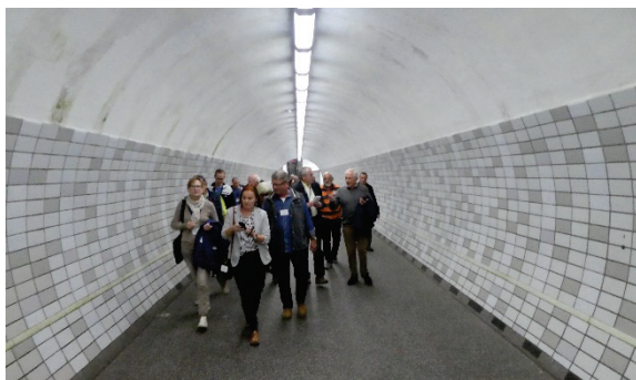
Bild 8 Der Fußgängertunnel unter dem Nordostsee-Kanal
